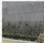
Structure câbles inox tendus
